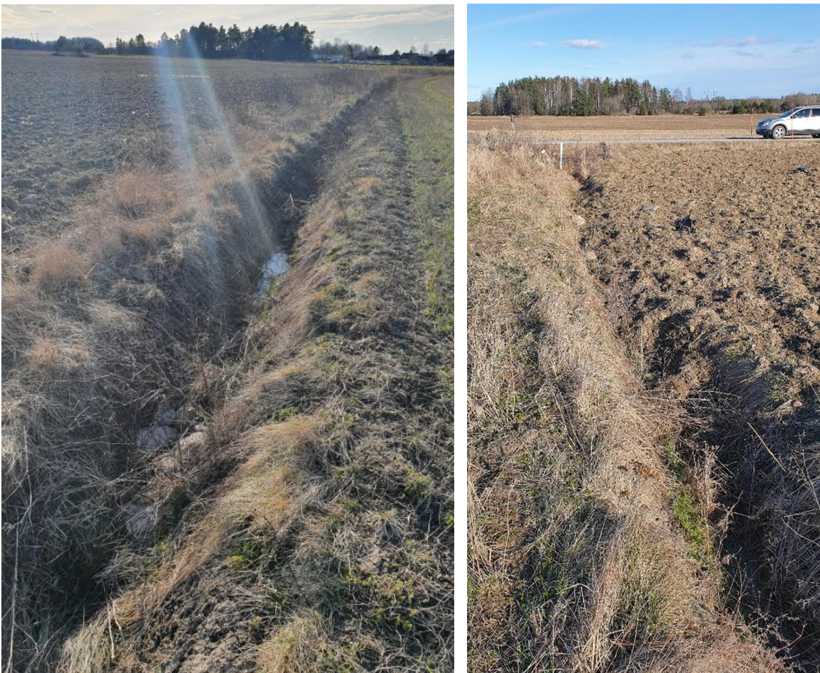
Figur 6. Befintligt dike inom utredningsområdet, tv foto taget mot väster, th foto taget mot Rabbstavägen i öster. 2020-03-13.
