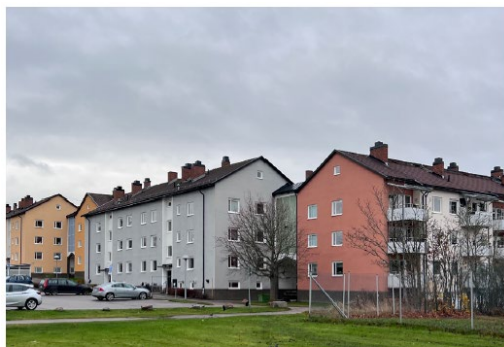
Sammankopplade lamellhus mot Ringvägen/Hammargatan
