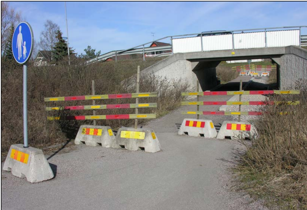
Tunneln under Ringvägen
