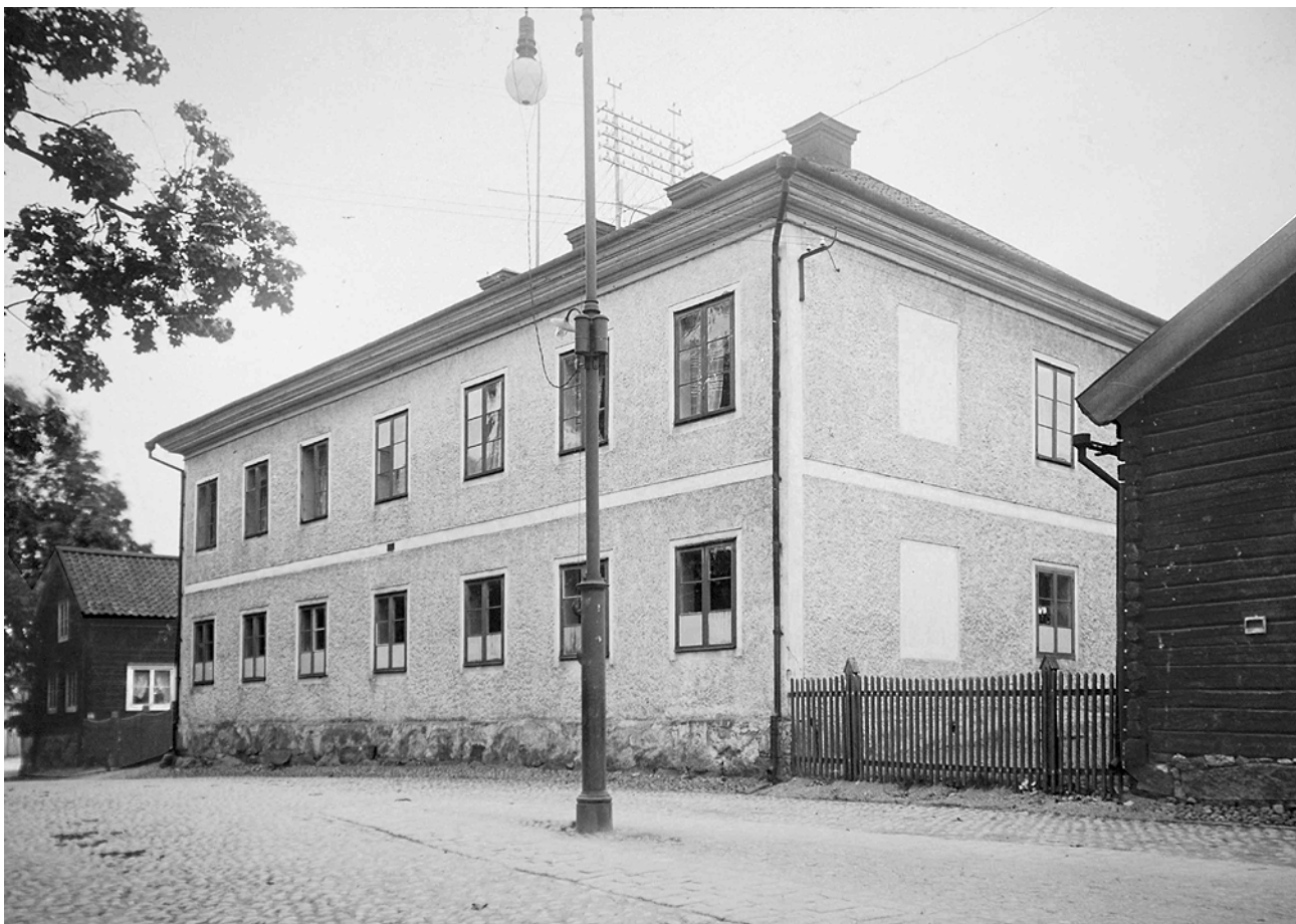
Från nordväst, omkring 1907. Här är de ursprungliga fönstren fortfarande kvar, liksom fasaddekoren. Sockeln har ett ojämn ljus färg, antagligen en tunn puts (slamning). Fönster och skorstenar är mörka.
