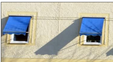
Fönster m. profilering o. slätputs på fasaden.
