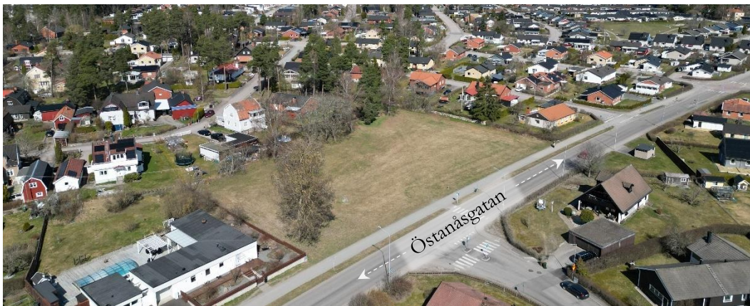
Drönbild över förtätningssytan och omgivande bebyggelse.
